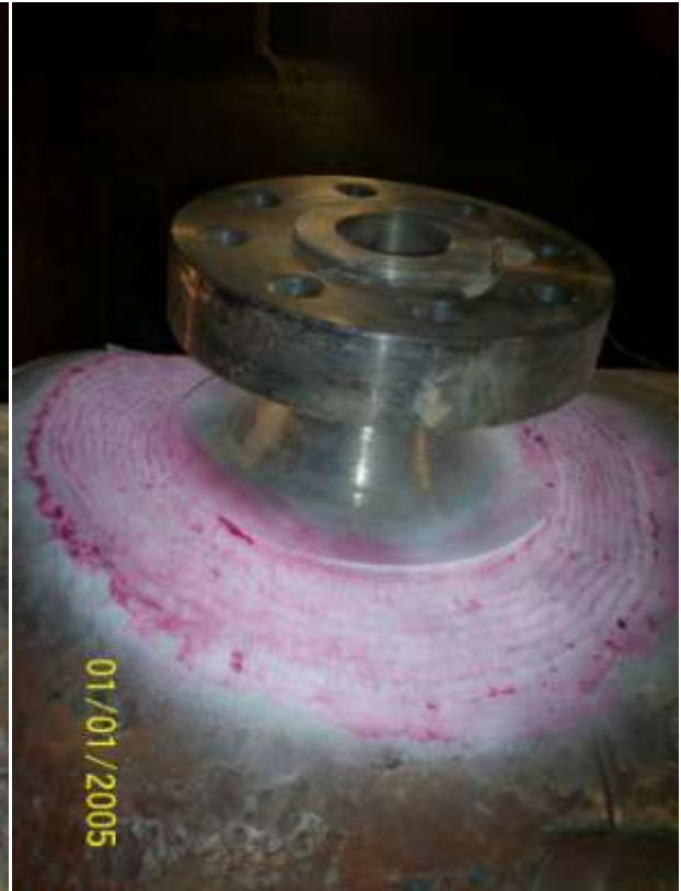
Cambio de Brida de Cilindro Prensa (Espesor 150 mm)
