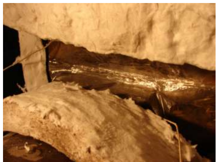
Reparación de Cuello de Brida Carcasa Turbina
