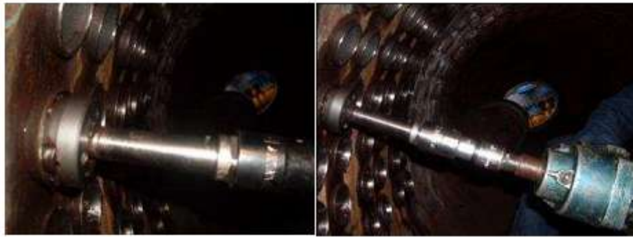
TUBOS MANDRILADOS EN DOMO SUPERIOR
