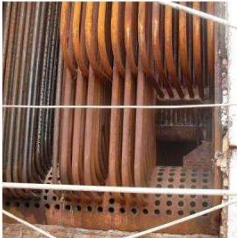
Reemplazo total del Haz Convectivos
