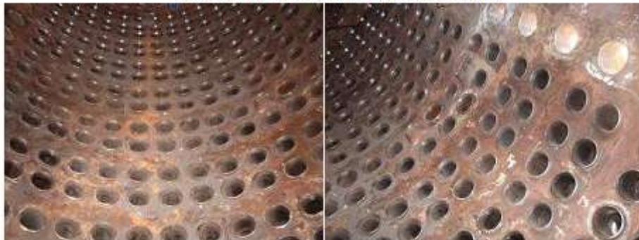
TUBOS MANDRILADOS EN DOMO SUPERIOR
